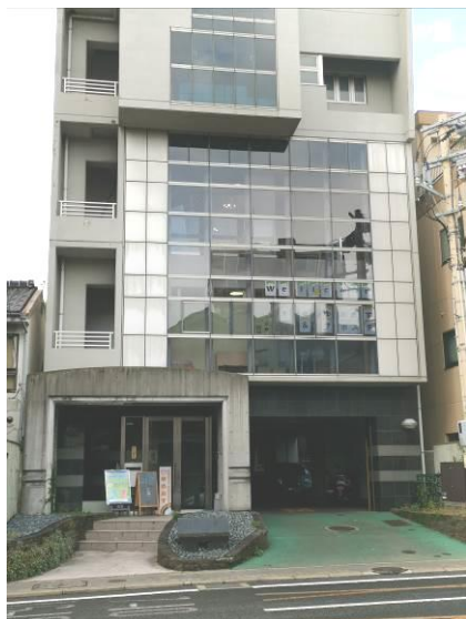
1 階に駐車場がある建物が目印
