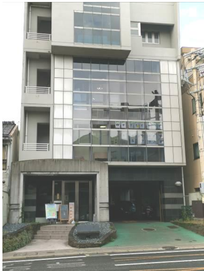
1階に駐車場がある建物が目印
